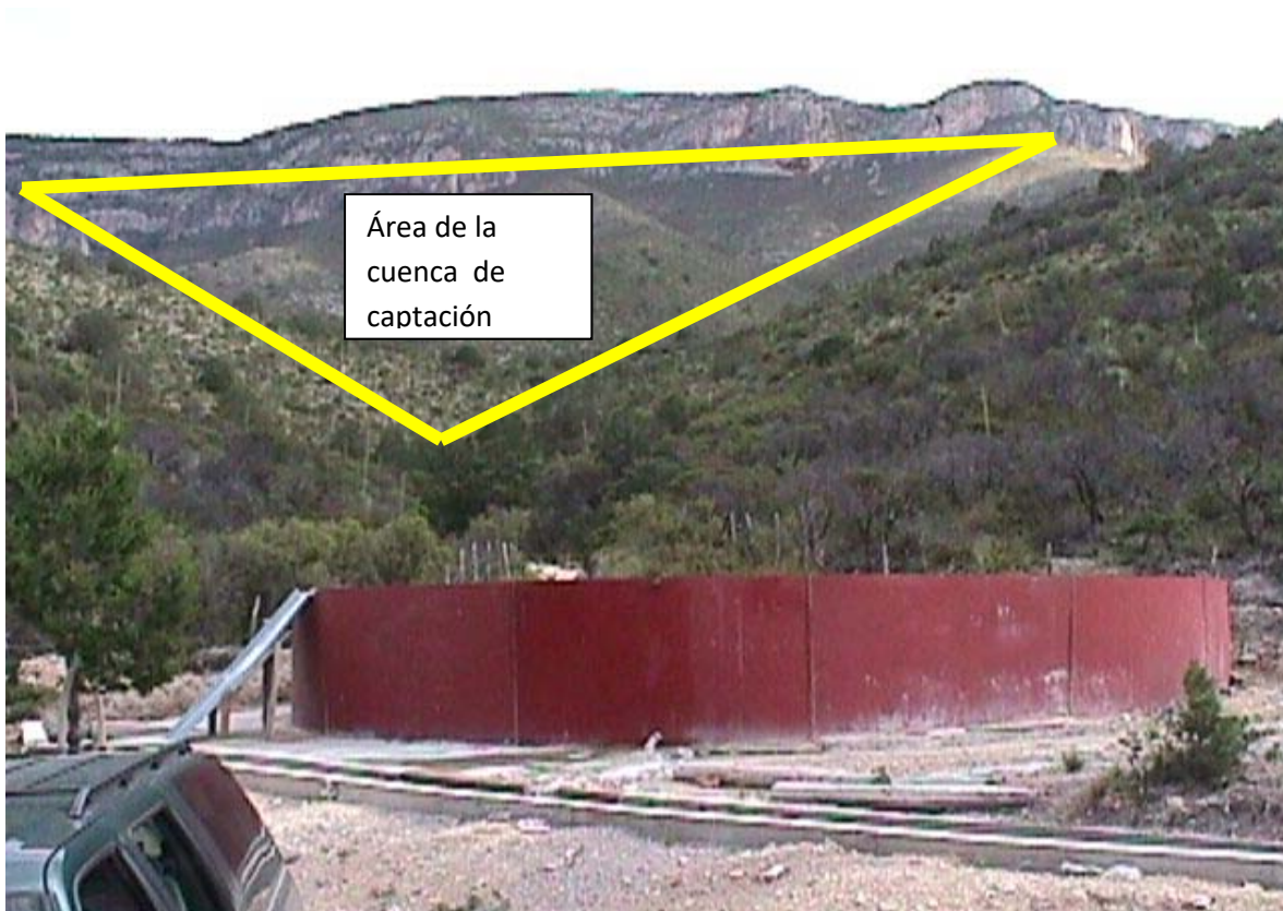
Anexo 1. Cuenca hidrológica para captar la lluvia y tanque principal de cosecha o almacenamiento de agua. Arriba a la izquierda, vertedor que conecta con el canal de concreto para conducir el agua a los depósitos secundarios.
