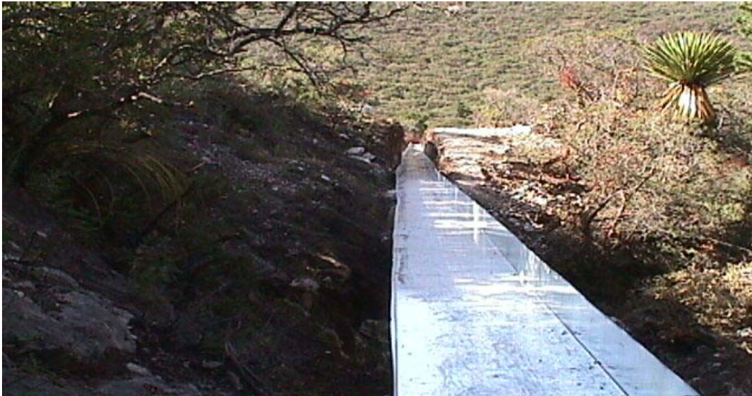
Anexo 2. Canal de conducción del agua captada, desde una pequeña cortina de concreto, al depósito principal.
